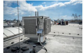
... das auf dem natürlichen Prinzip der Verdunstungskühlung beruht
